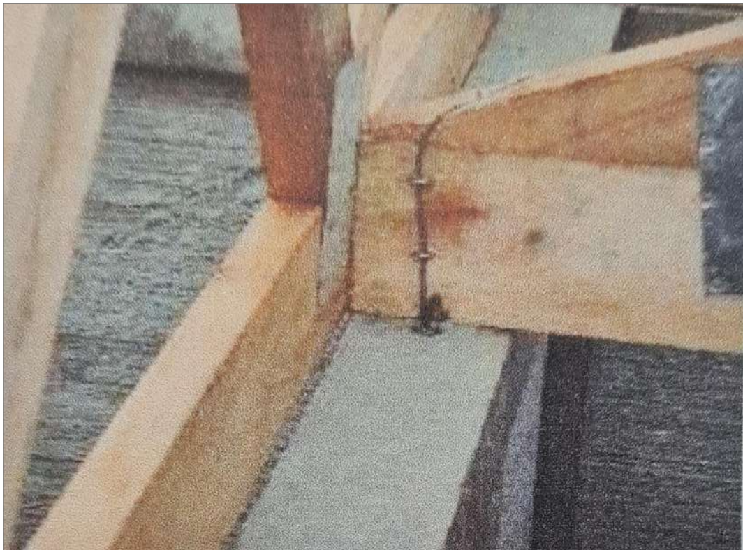
RIGIDIZACIÓN DE LA VIGA CARRERA / PILAR / CERCHA
